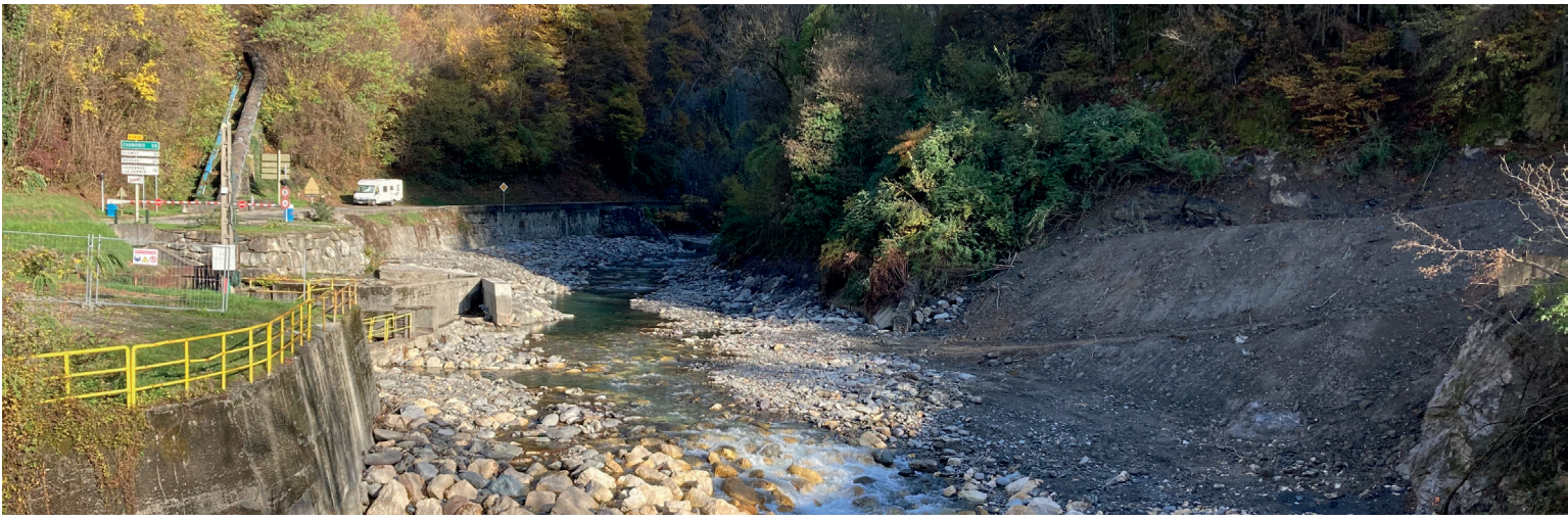
Nouvelle rampe du seuil des Mollières
