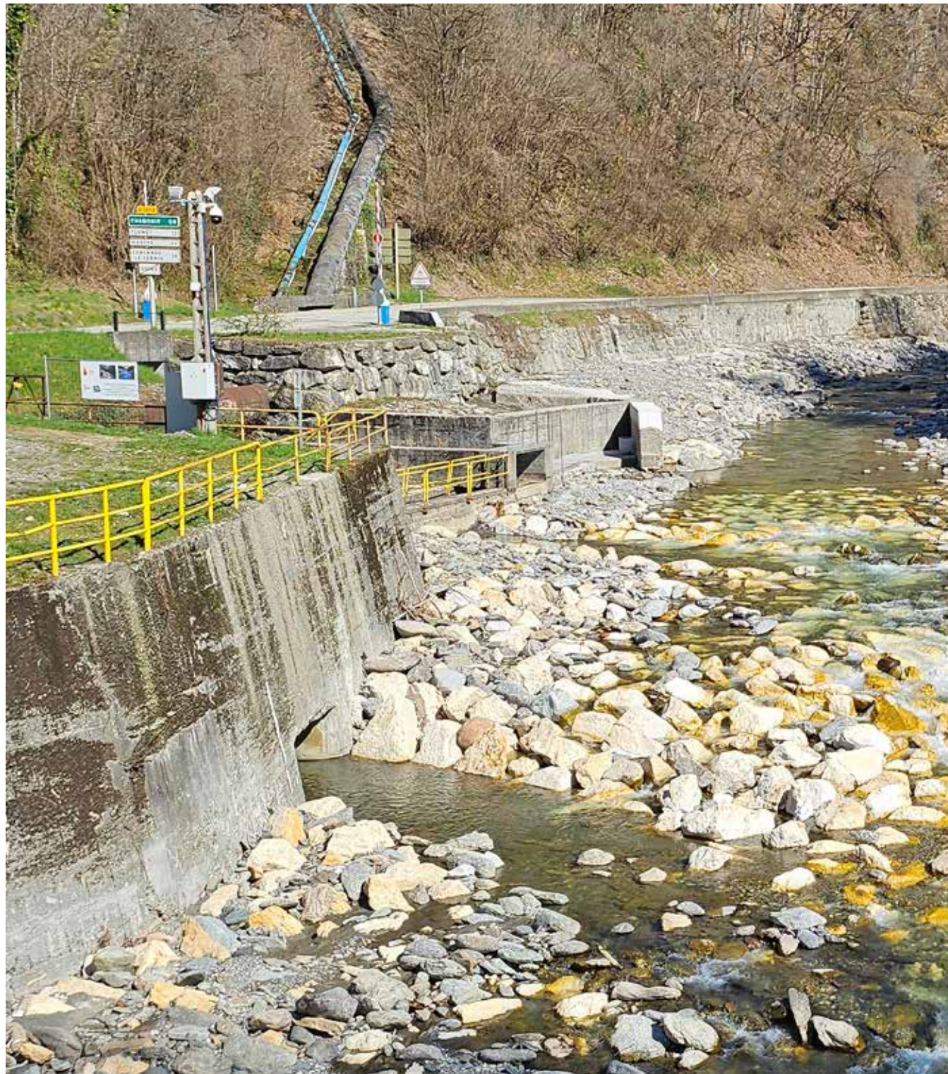
Seuil des Mollières après travaux
