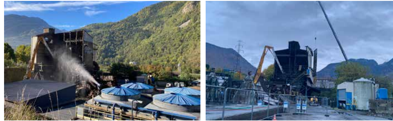
Déconstruction sur le site de la Léchère
