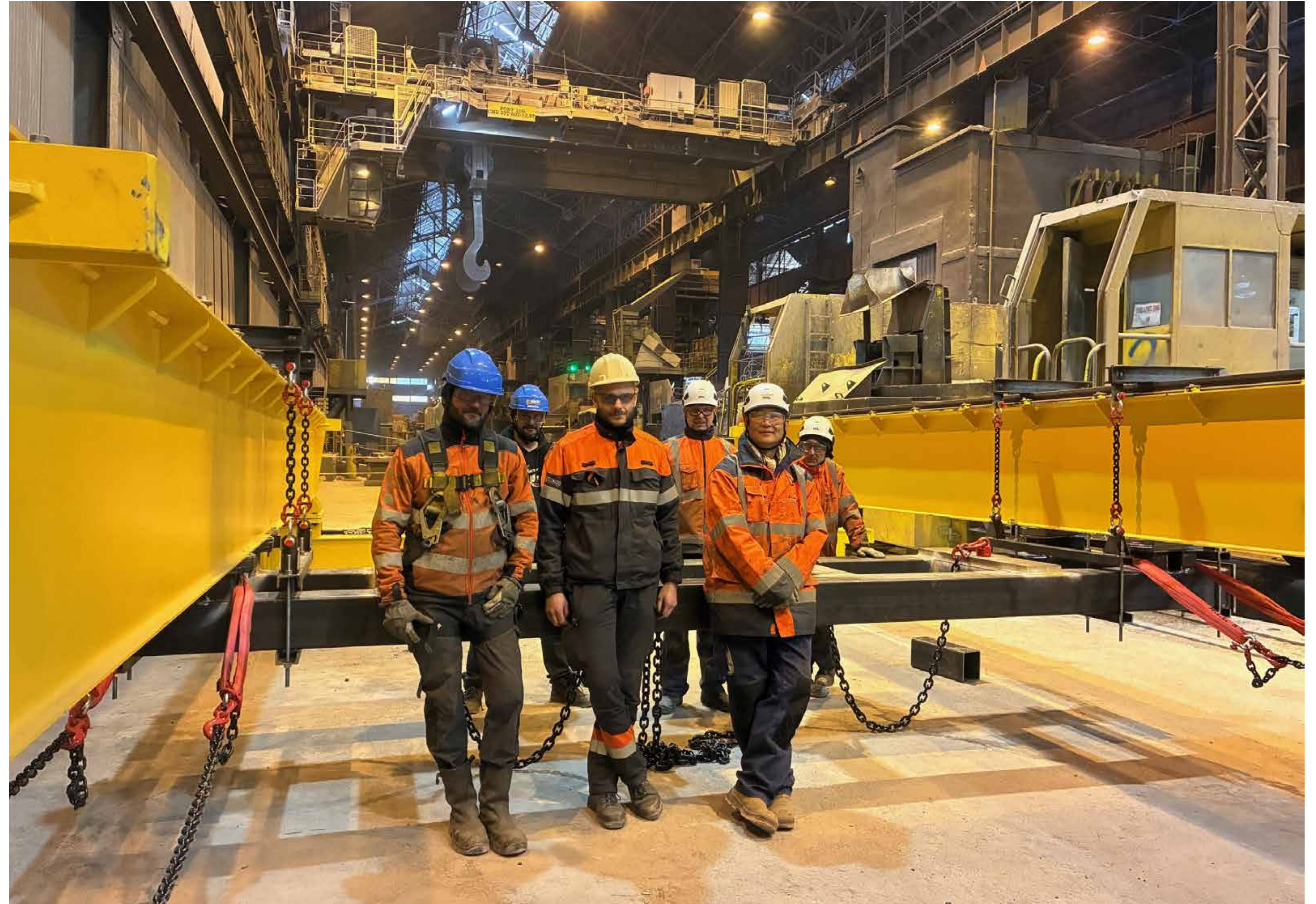
Remplacement d'un pont à l'aciérie avec la société SECAL
