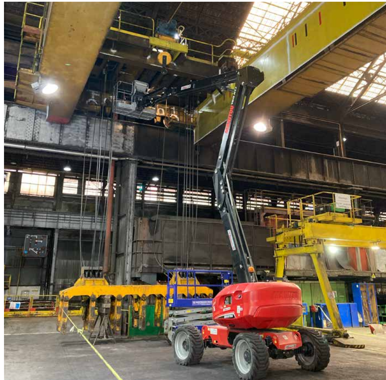
Intervention sur pont roulant avec nacelle élévatrice
